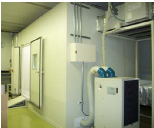
図 4-10 独立空調型断熱ブース（外観）
