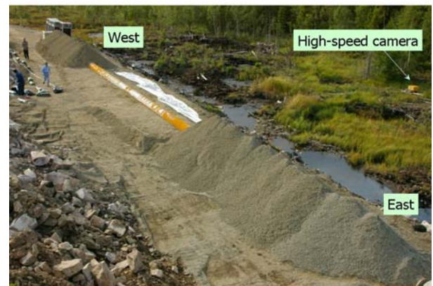
図 4 実大バースト試験体の設置状況
