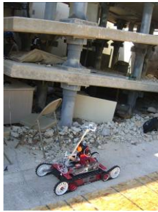
(d) 倒壊建物
