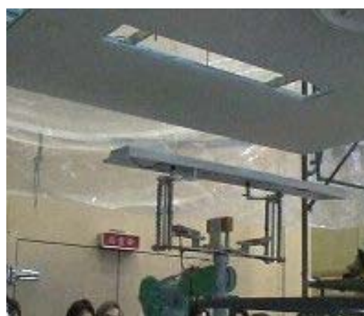
図 3-4 蛍光灯パネルの回収
