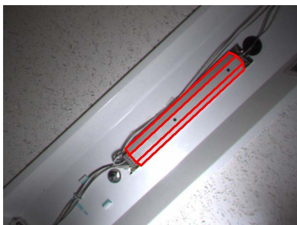
図 3-5 可変照明機構による照明
