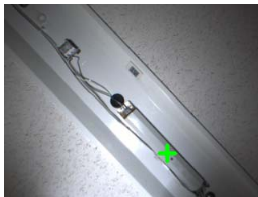
図 3-3 作業者による対象物の指示
