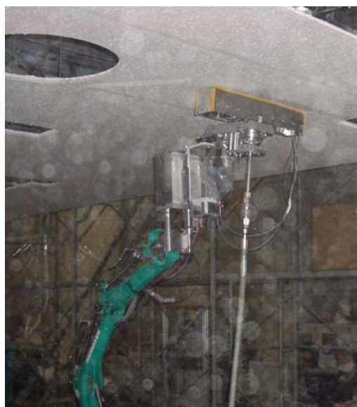
図 2-4 天井ボード切断状況
