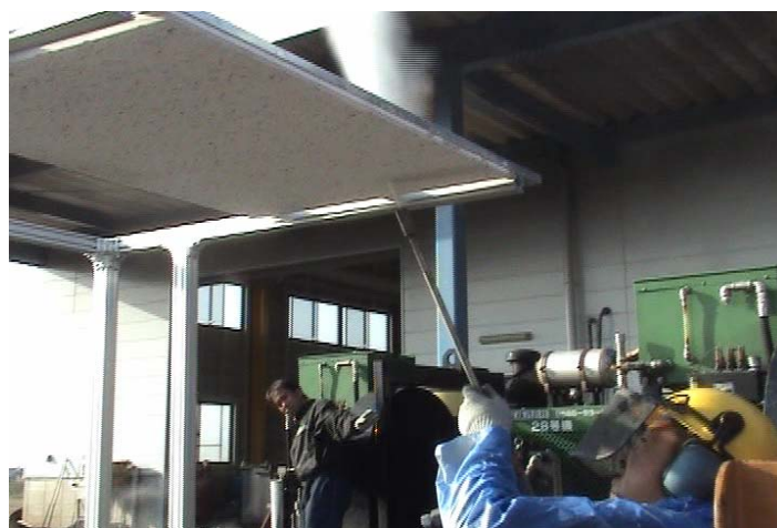
図 5-1 人手による天井ボードの解体
