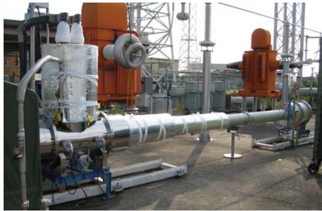
図 2.1.3-6 中間接続部 過冷却通電試験状況
