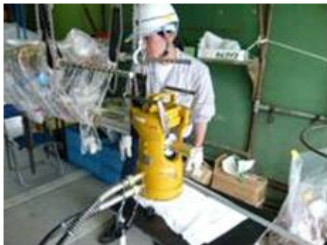
(e) 導体接続金具の圧縮
